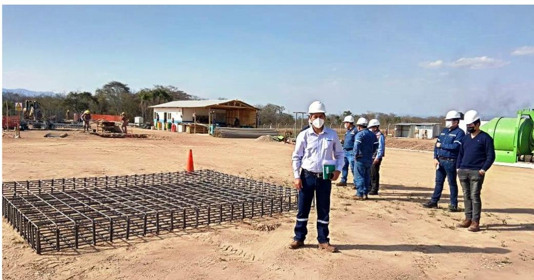
Subestación Bermejo: Estructura metálica de fierro utilizada como base para las fundaciones del pórtico.
